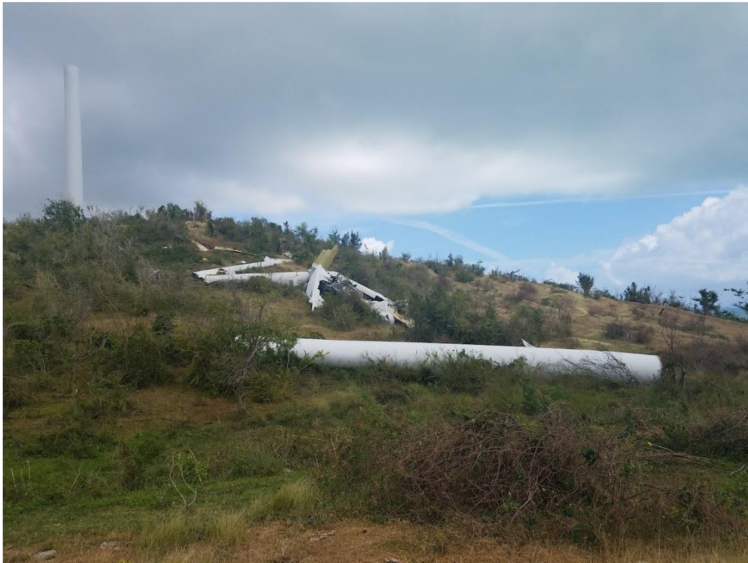
Figura 25 – Turbinas eólicas inoperables y averiadas en el parque eólico Punta Lima luego del paso del huracán María por Naguabo, Puerto Rico
