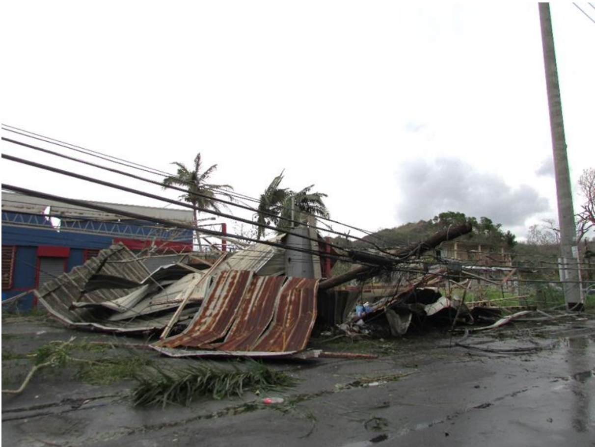
Figura 26 – Poste de madera de distribución eléctrica afectado por el Huracán María en Trujillo Alto, Puerto Rico
